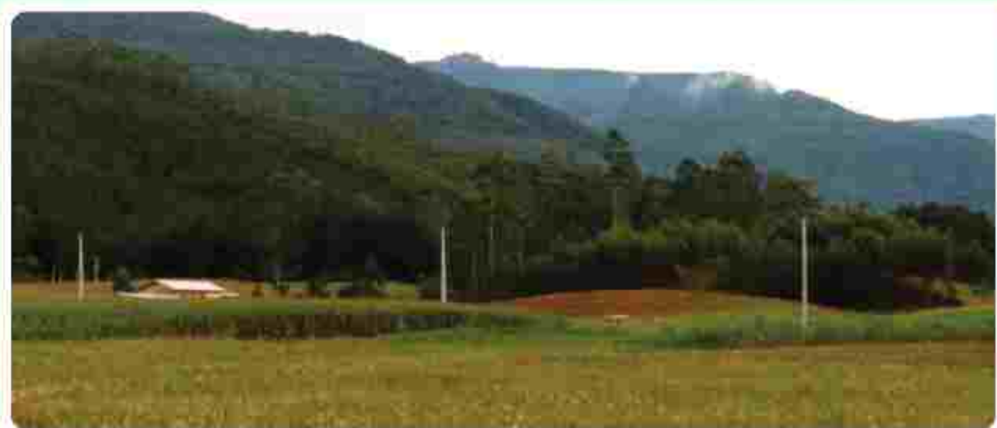
Alteração/Reforma de rede na localidade de Três Barras
