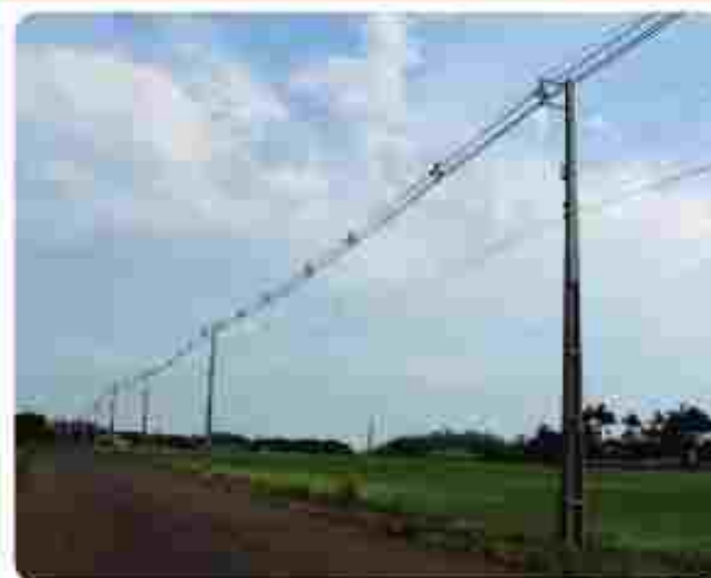
Alteração/Reforma de rede utilizando-se de estrutura compacta na localidade de Turvo Baixo - Parte 2
