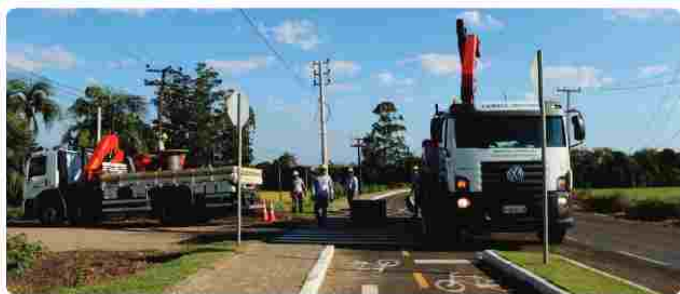
Alteração/Reforma da rede próximo à Escola Municipal no Centro na Rodovia BR 285
