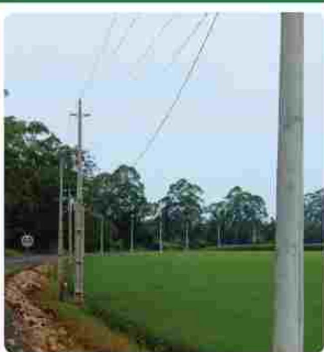
Reforma de rede na localidade de Rio Aparecida
