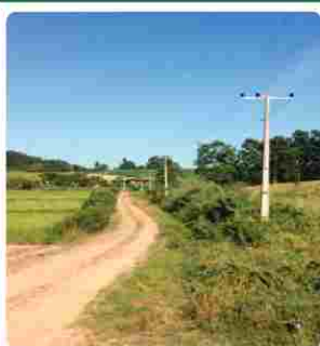
Reforma de rede na localidade de Morro do Santana
