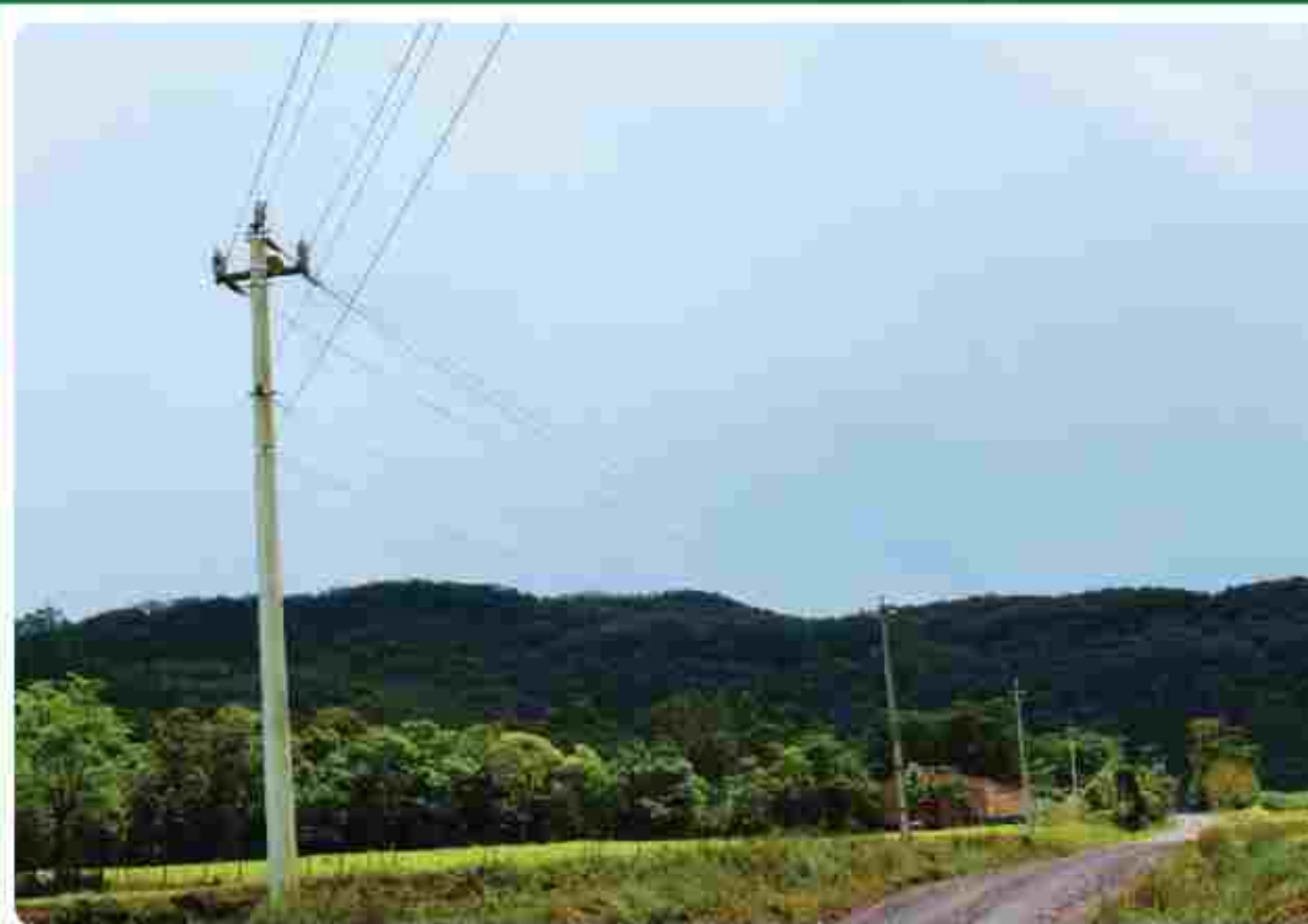
Ampliação/Reforma de rede na localidade de Morro Azul
