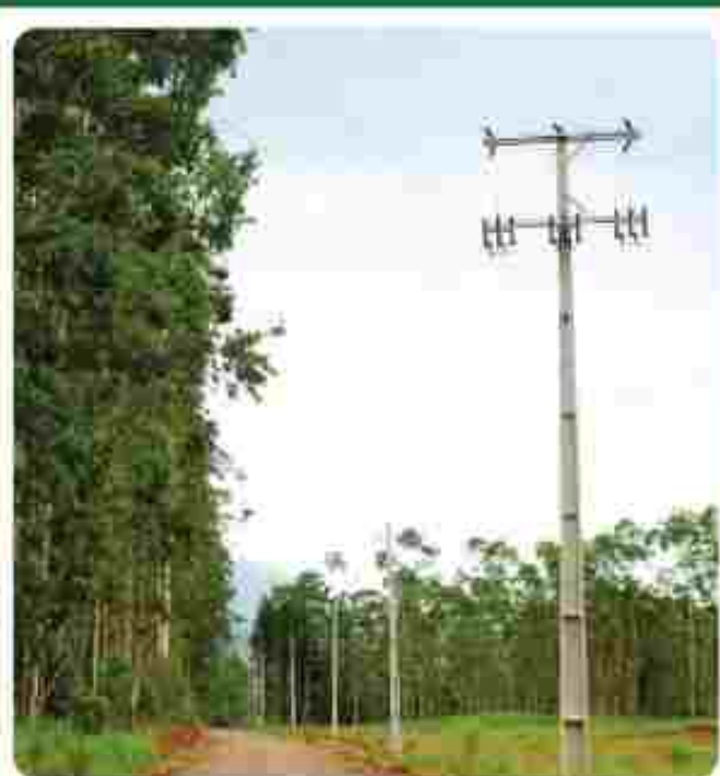
Alteração para trifásico na localidade de Vila Belmiro
