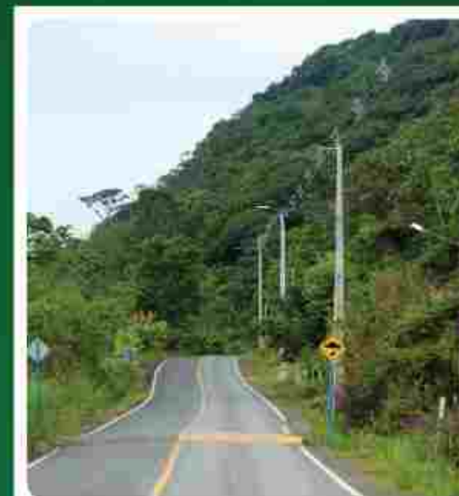
Construção de rede compacta no morro do Novo Paraíso
