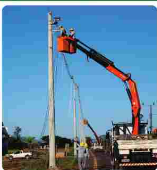
Alteração/Reforma de rede utilizando-se de estrutura compacta na localidade de São Felipe
