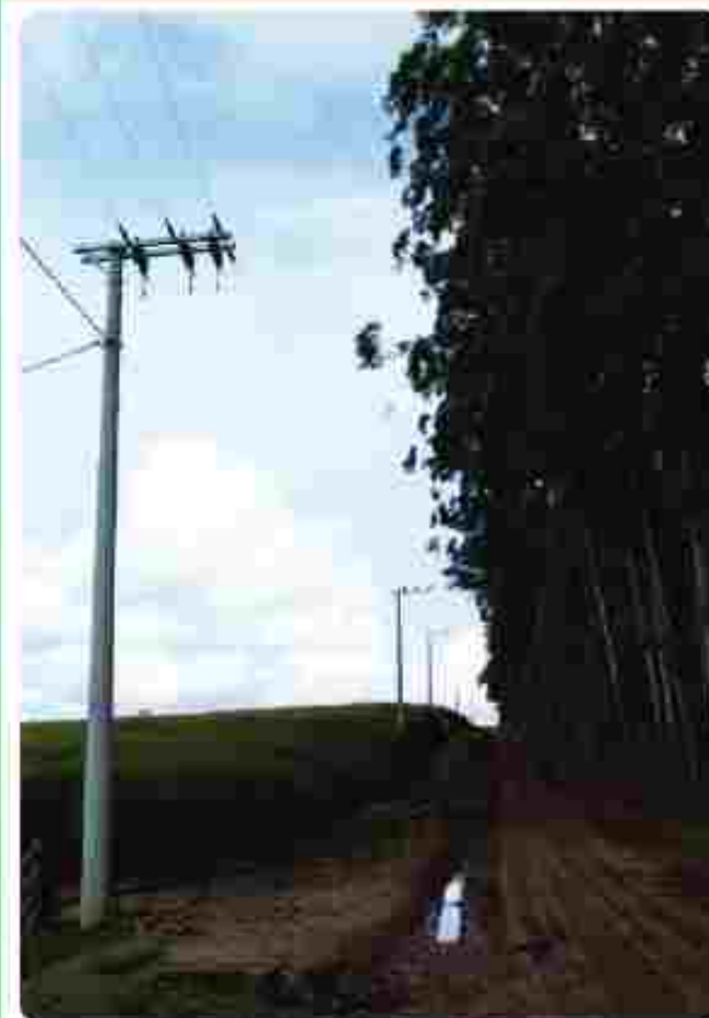
Construção de rede para fechamento de Anel Elétrico na localidade de Garapuvu
