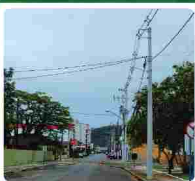
Ampliação/reforma e instalação de novos transformadores na rede do Centro
