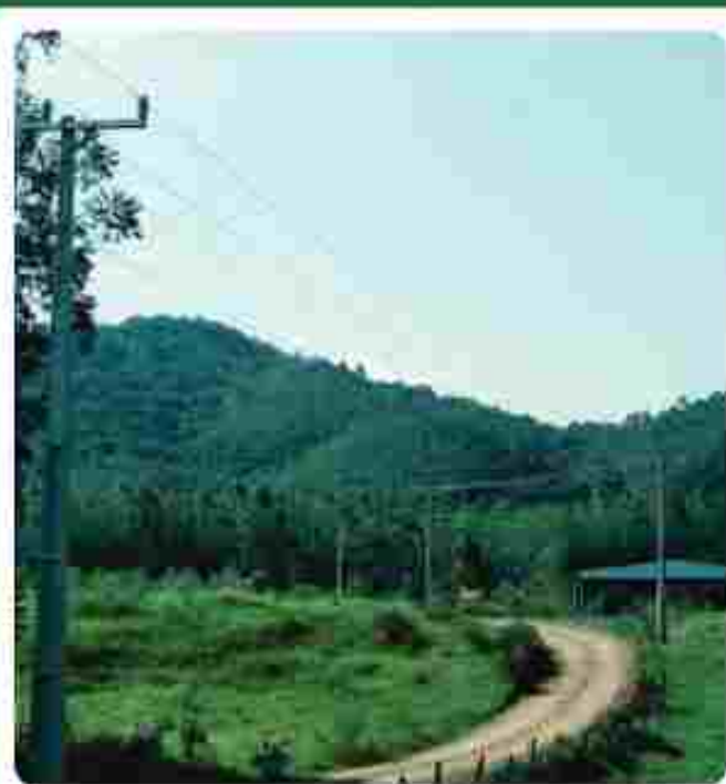
Construção de rede trifásica no Parque Industrial de Timbé
