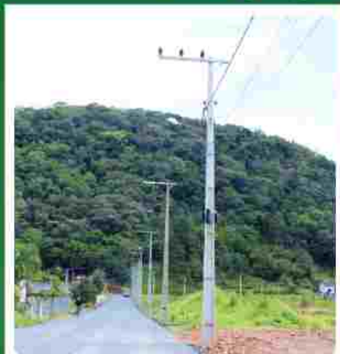
Alteração/reforma de rede no bairro Jardim América
