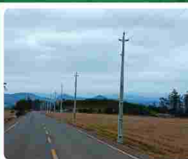
Alteração/Reforma de rede entre as localidades de Ponte Alta e Costa do Rio Pinheirinho
