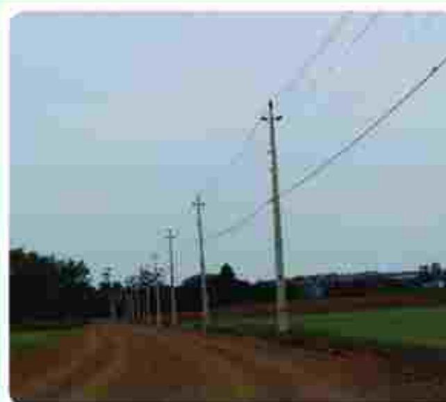
Reforma de rede nas proximidades do parque industrial em direção a Linha Jundiá
