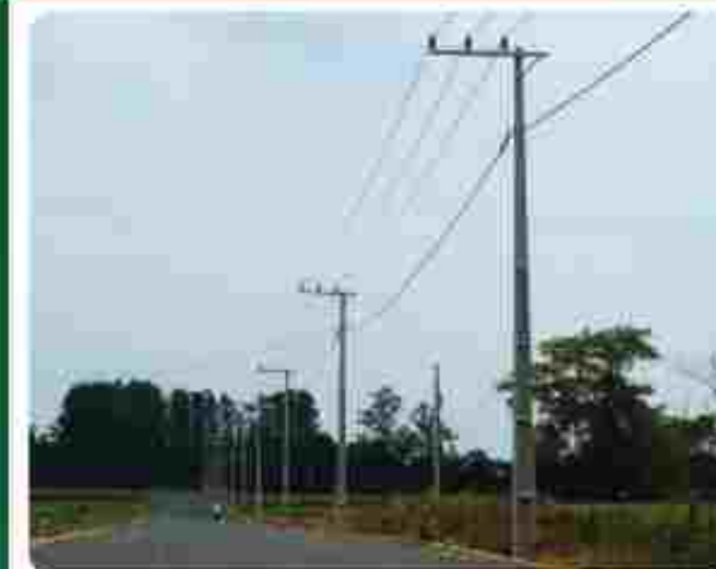
Construção de rede na parte nova da Rua Usílio Tonetto, devido ao anel viário
