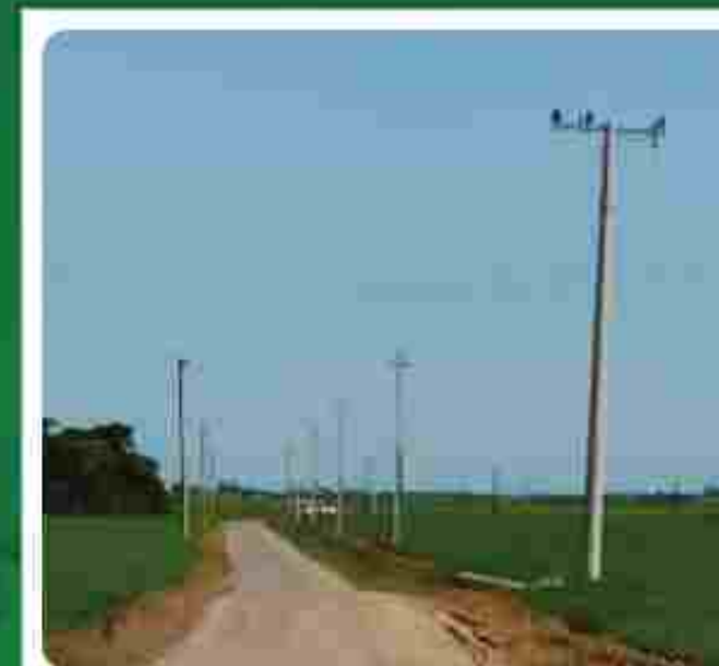
Alteração de rede para trifásico na localidade de Morro do Bodoque
