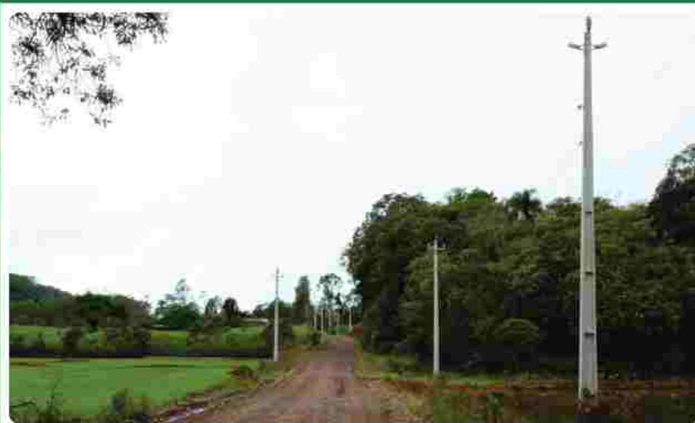
Construção de rede para fechamento de Anel Elétrico na localidade de Santa Luzia
