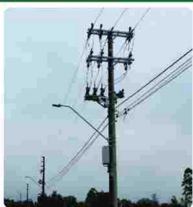
Substituição de Religador na Localidade de São Bento
