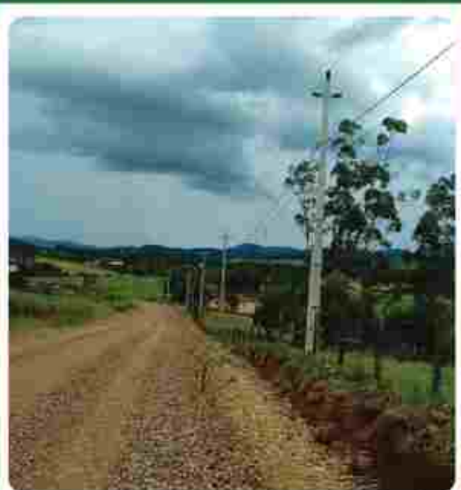
Reforma de rede entre as localidades de Morro do Ermo e Vista Alegre
