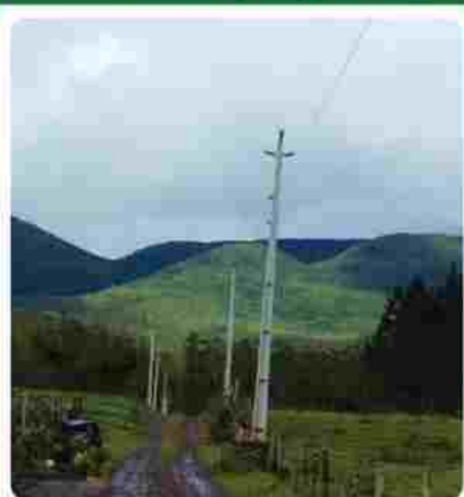
Reforma de rede na localidade de Três Barras
