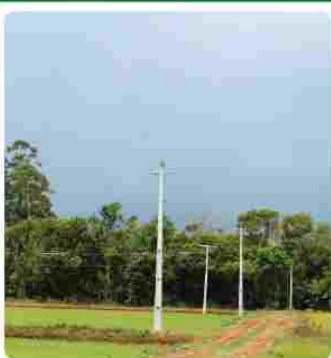
Reforma de rede e alteração para trifásico na localidade de São Felipe (Bombas de Irrigação)
