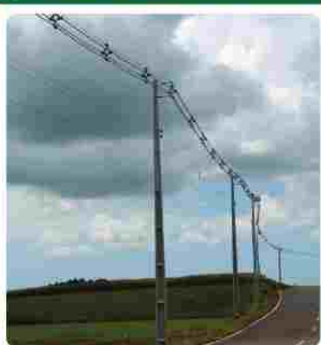
Reforma de rede em Boa Vista/rota alternativa para alimentação de Morro Grande e Morro Chato (rua de Turvel)
