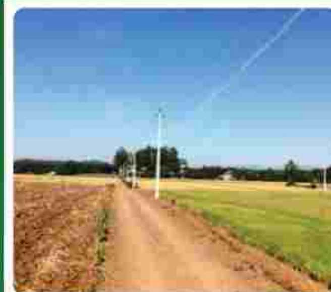
Reforma de rede na localidade de Livramento
