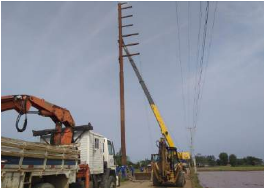
Imagem 14: Montagem da estrutura
