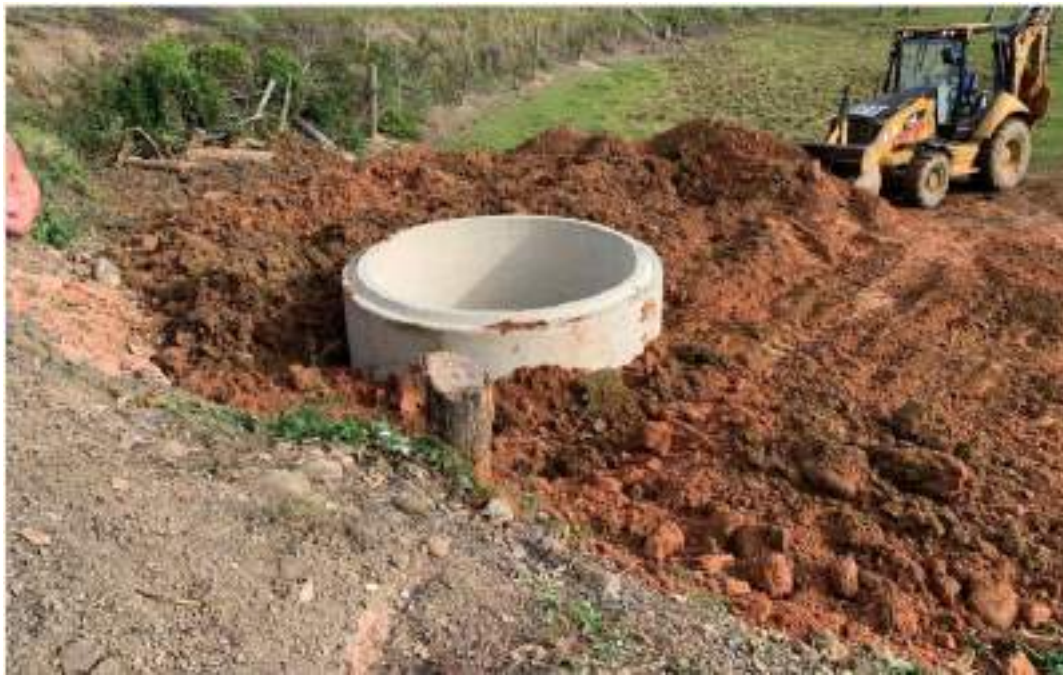
Imagem 11: Montagem da estrutura
