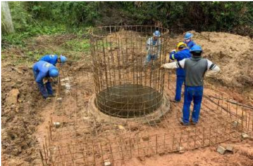
Imagem 12: Montagem da estrutura
