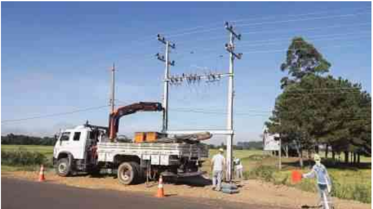
Imagem 7: Instalação banco regulador de tensão - Soares; Ermo.
